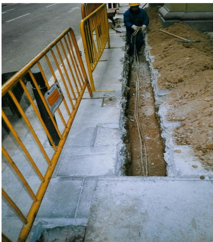
F 3. Rasa 1000. C/ del Dr. Joaquim Pou. Procés d'extracció de l'antic cable elèctric que travessava la rasa.
