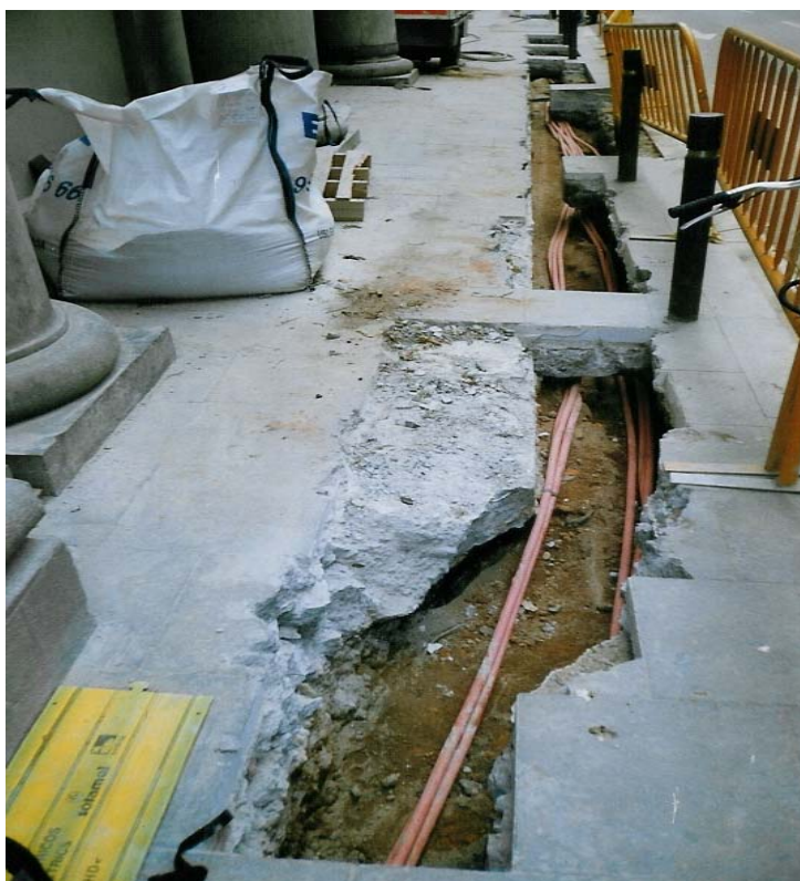
F 6. Rasa 2000. C/ del Dr. Joaquim Pou. Finalitzada amb presència del cablejat ja existent.
